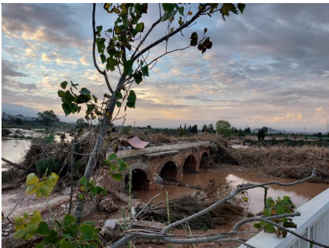
Pont Vell tras la riada del 29 de octubre del 2024.
